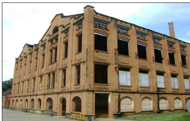
Figura 2: Prédio Principal do Engenho central de Piracicaba. Fonte: SEMAC/Piracicaba, 2010.
